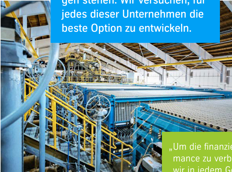
Elektrolyseanlage zur Erzeugung von grünem Wasserstoff
