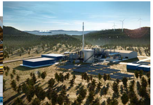
Ammoniak-Anlage für die Realisierung von Green-Ammonia-Projekten
